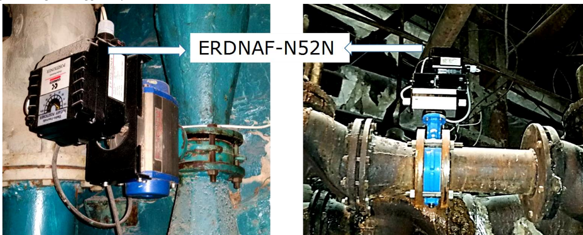
Рис.2. Приклад реалізації адаптивного керування для вимірювання умовної пропускної здатності поворотних заслінок (в залежності від кута повороту диска при керуванні слідкувальним приводом ERDNAF-N52N).
