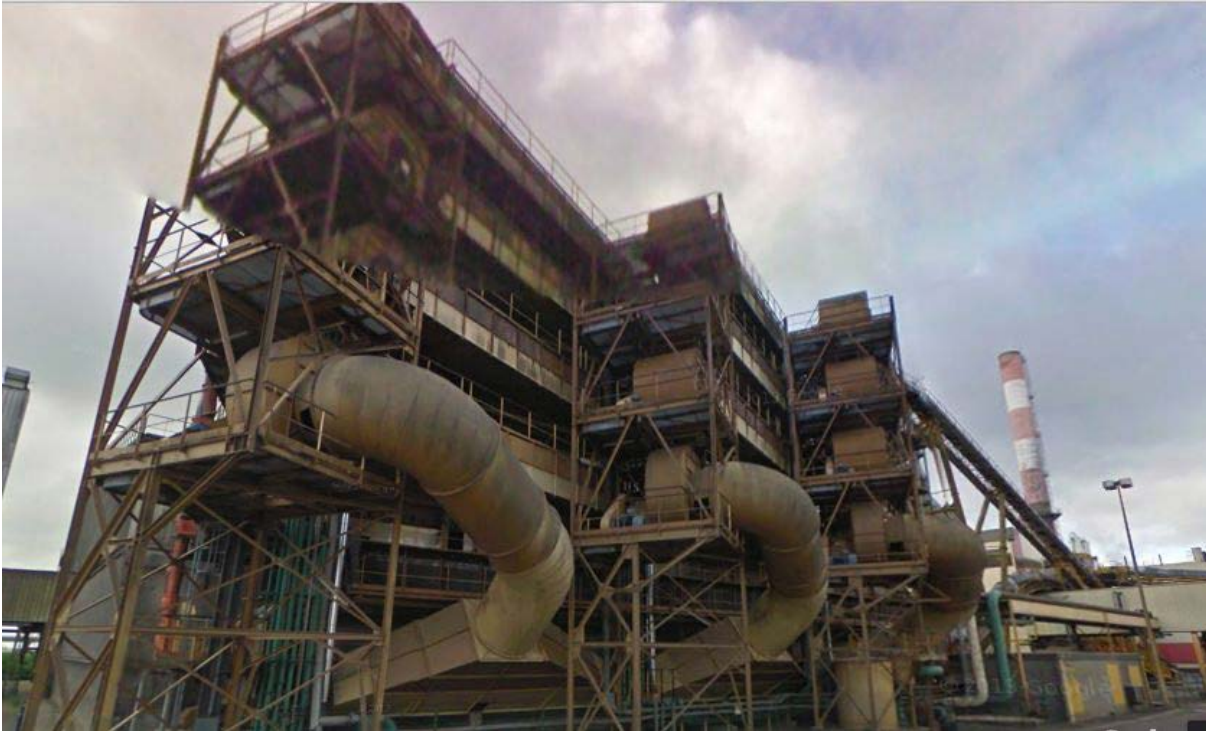
Рис. 21. Конвективна стрічкова сушарка для жому теплою утфельної пари на цукровому заводі Артене [Artenay], Франція (взято з google.maps, координати пш=48,09097° та сд=1,886448°).
