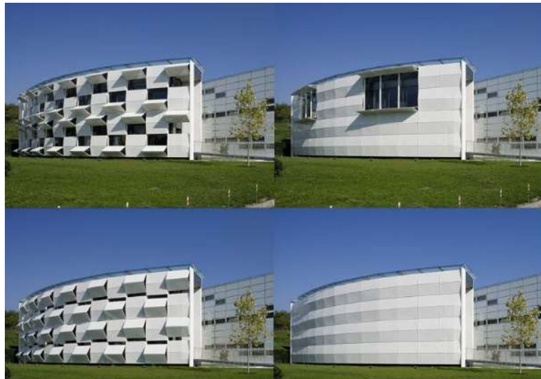
Рис. 2 Динамічна будівля із змінним фасадом
