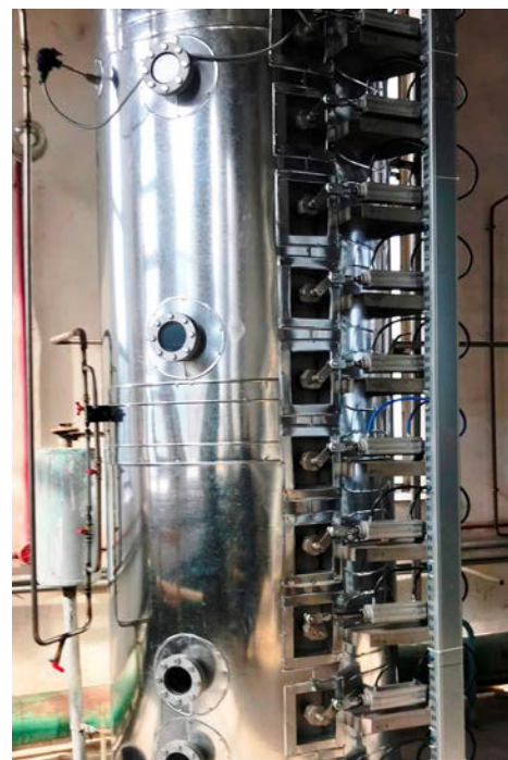
Рис. 1. Експериментальна розгінна колона циклічної дії
