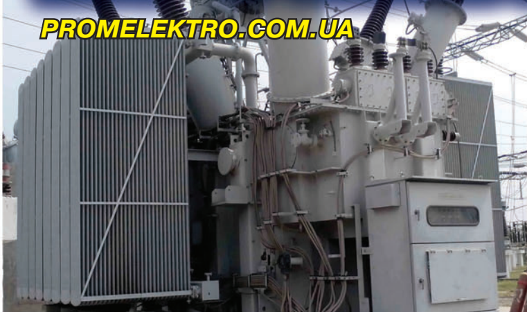
АНАЛІЗ ПОТОЧНОГО СТАНУ ЗАЗЕМЛЕННЯ СИСТЕМИ БЛИСКАВКОЗАХИСТУ ПІДСТАНЦІЙ УКРАЇНИ с. 18
