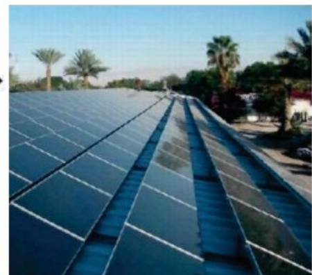
Рис.12. Фотоелектричні перетворювачі на основі монокристалічного кремнію
