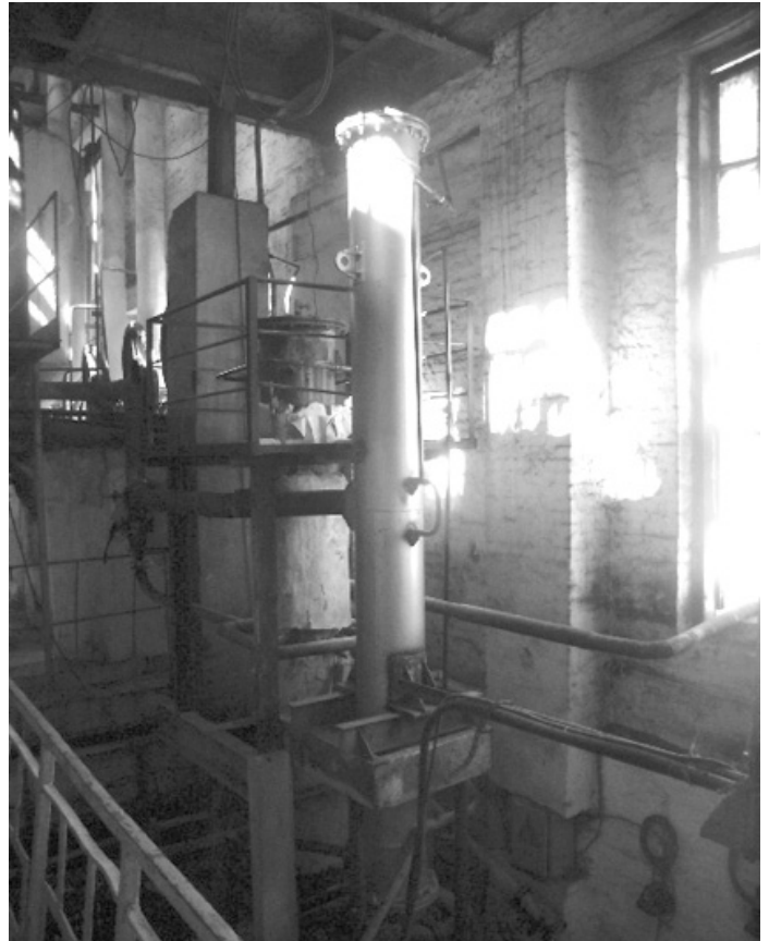
Рис.4. Вид змонтованого підігрівника «білої» потоки I кристалізації ПДС – 400 - 4
