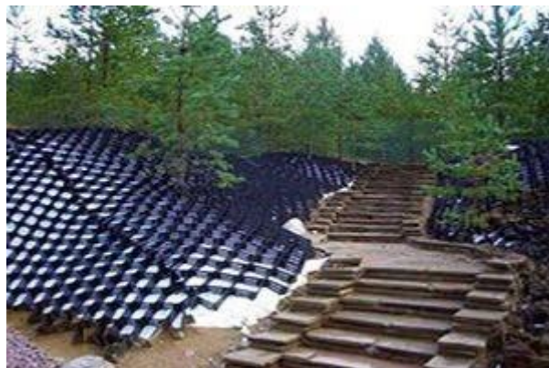
Рисунок 2.1 — Принцип терасування схилів відвалу
