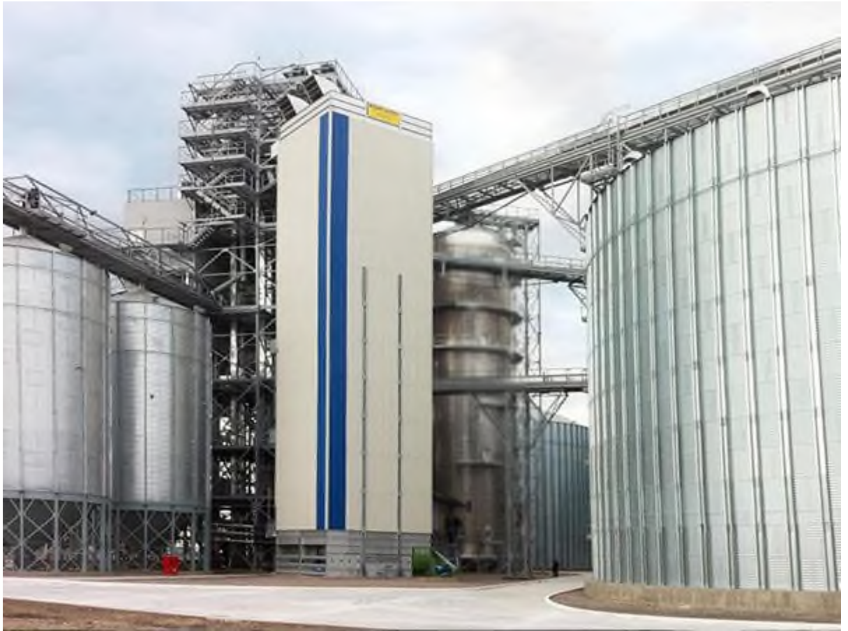
Рисунок 1.2 – Загальний вигляд зерносушарки
