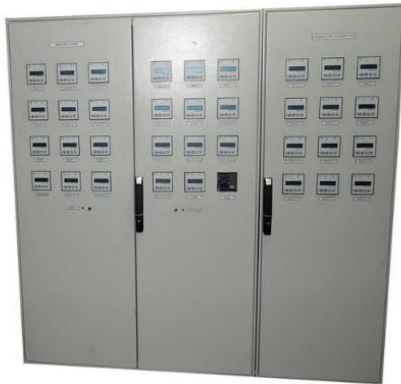
Рис.1.4.6. Щит управління випарним відділенням
