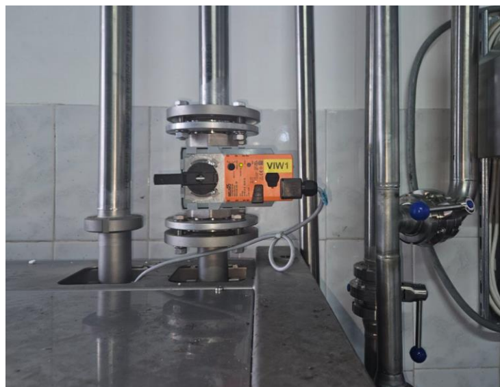
Рисунок 2.1.14 – Привод клапану, який вмонтовано в трубу на вхід продукту у скребковий охолоджувач.
