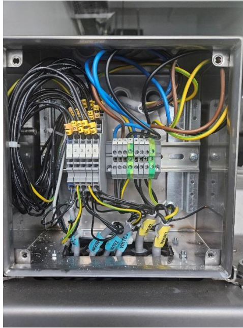
Рисунок 3.3.5 – підключення датчиків температури та тиску до клемної коробки скребкового охолоджувача.
