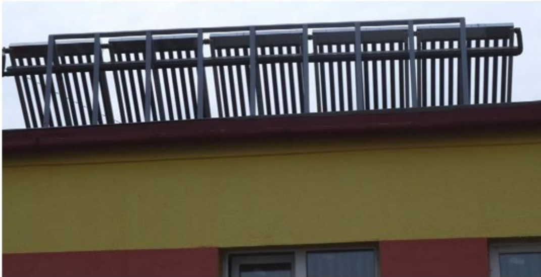
Малюнок 16. Розташування вакуумних сонячних колекторів на дахах ферм ВРХ (система підігріву питної води для тварин).
