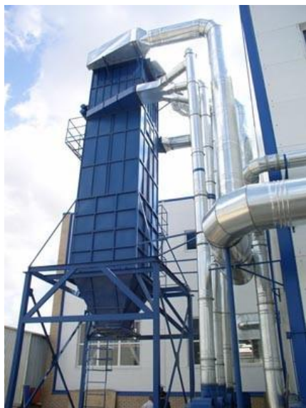
Рис. 11.5 Приклад готової аспіраційної установки
