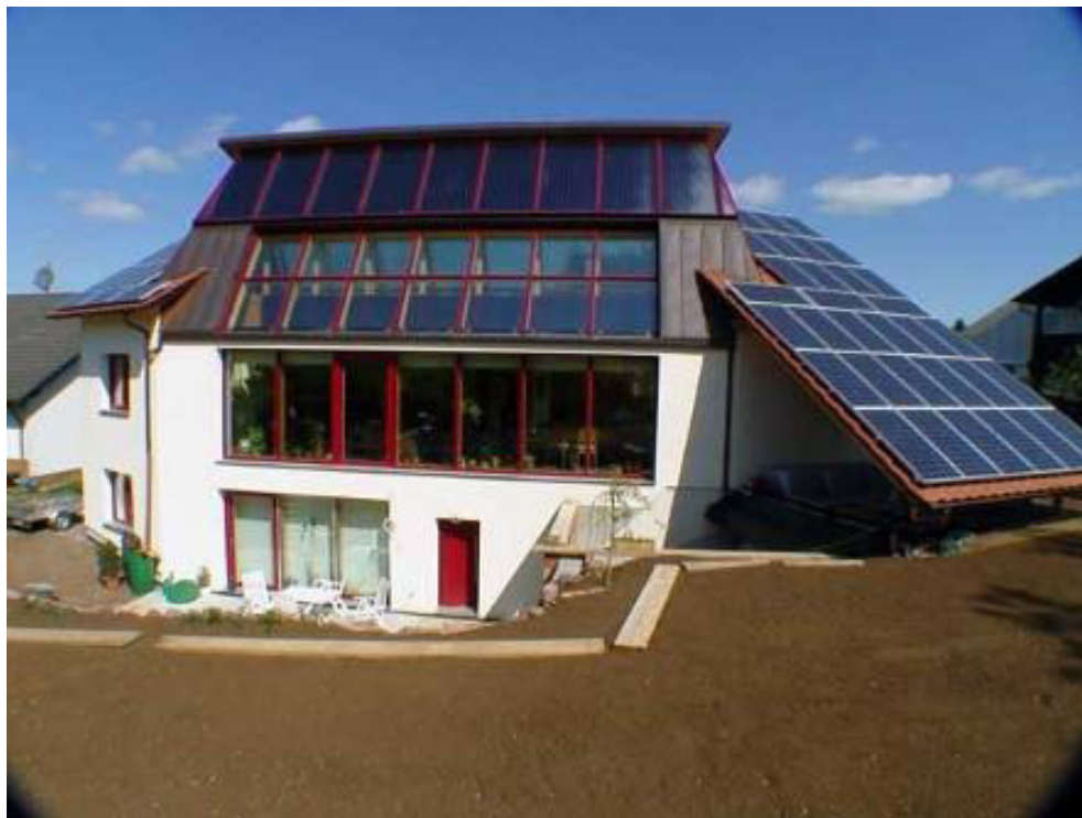
Рис. 1.8 - Зовнішній вигляд першого енергоефективного будинку
