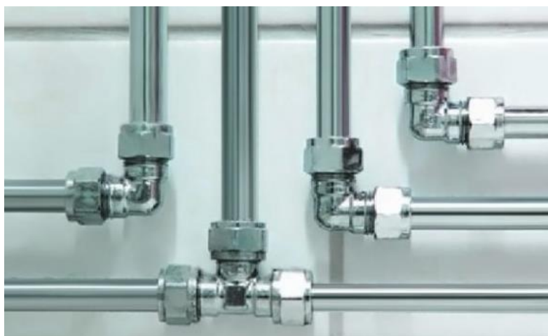
Рис.4.1 – Сталеві труби для водопроводу
