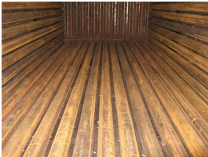
Рис. 1.3. Топковий простір котла ВК-32
