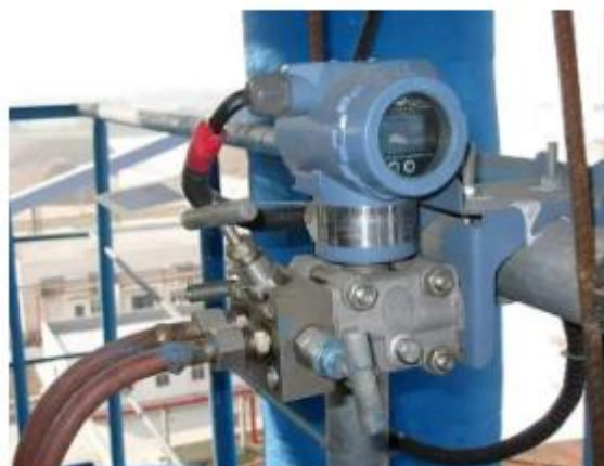
Рисунок 4.4 – Встановлення перетворювача за допомогою кронштейна
