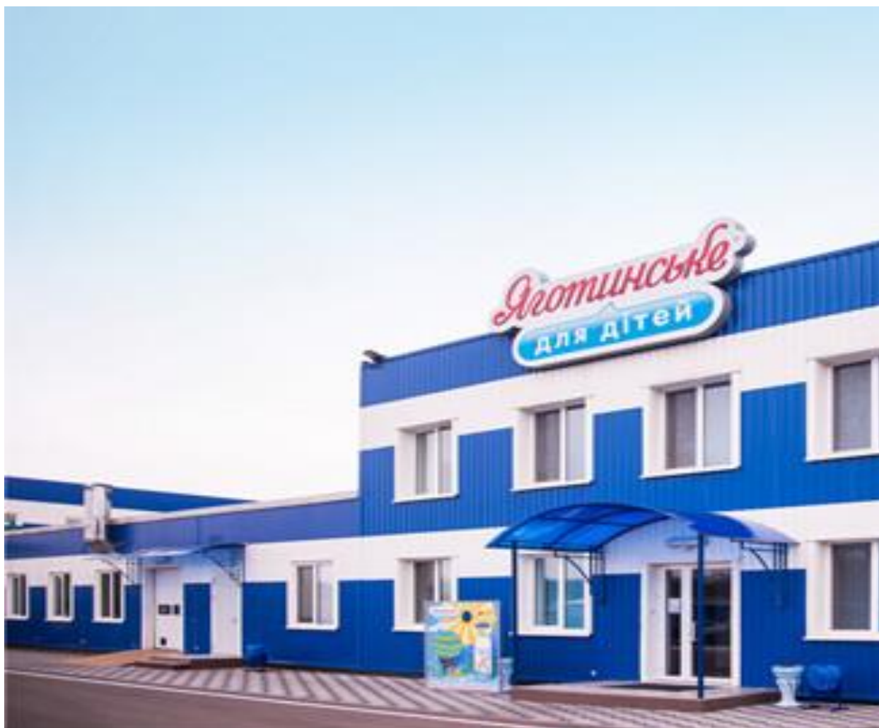
Рис. 2.2. Зображення будівлі Філії ТДВ «Яготинський маслозавод» «Яготинське для дітей»
