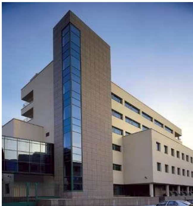
Рис. 4.1 - Фасад готелю в стилі конструктивізм
