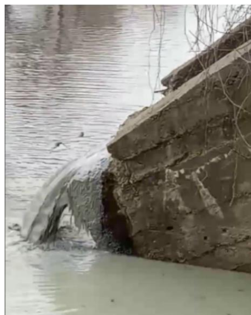
Рисунок 2.2 – Несанкціоноване скидання неочищених стоків у річку Тетерів через колектор зливових вод 22
