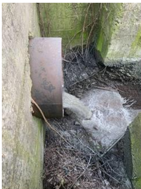
Рисунок 2.2 – Несанкціоноване скидання неочищених стоків у річку Тетерів через колектор зливових вод 22
