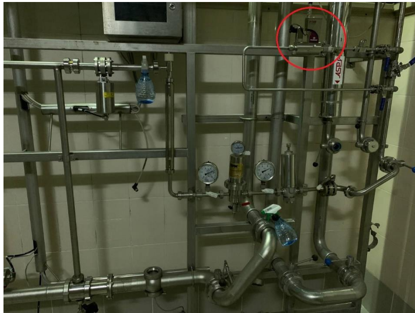
Рис. 4.2 – Панель аерації сусла
