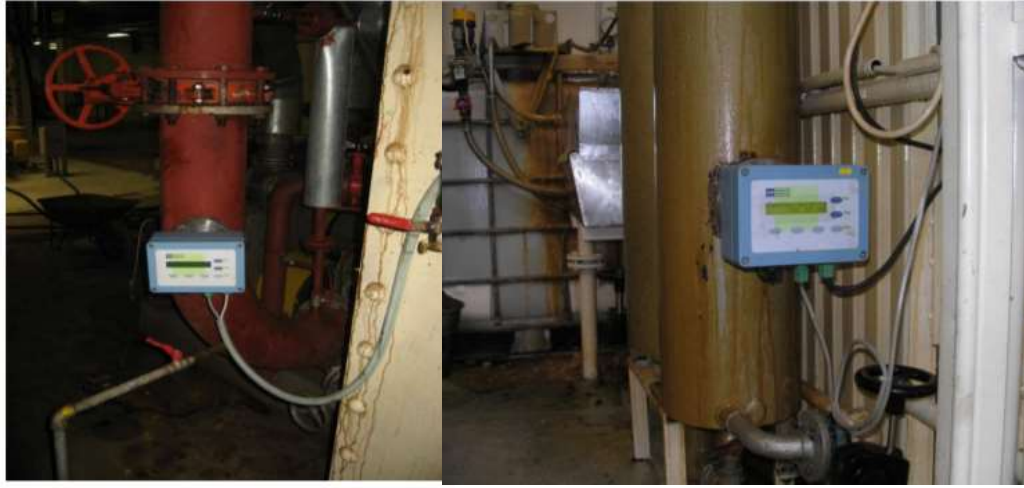
Рис. 2.14. Монтаж бриксометра Harrer-Kassen HK6-F
