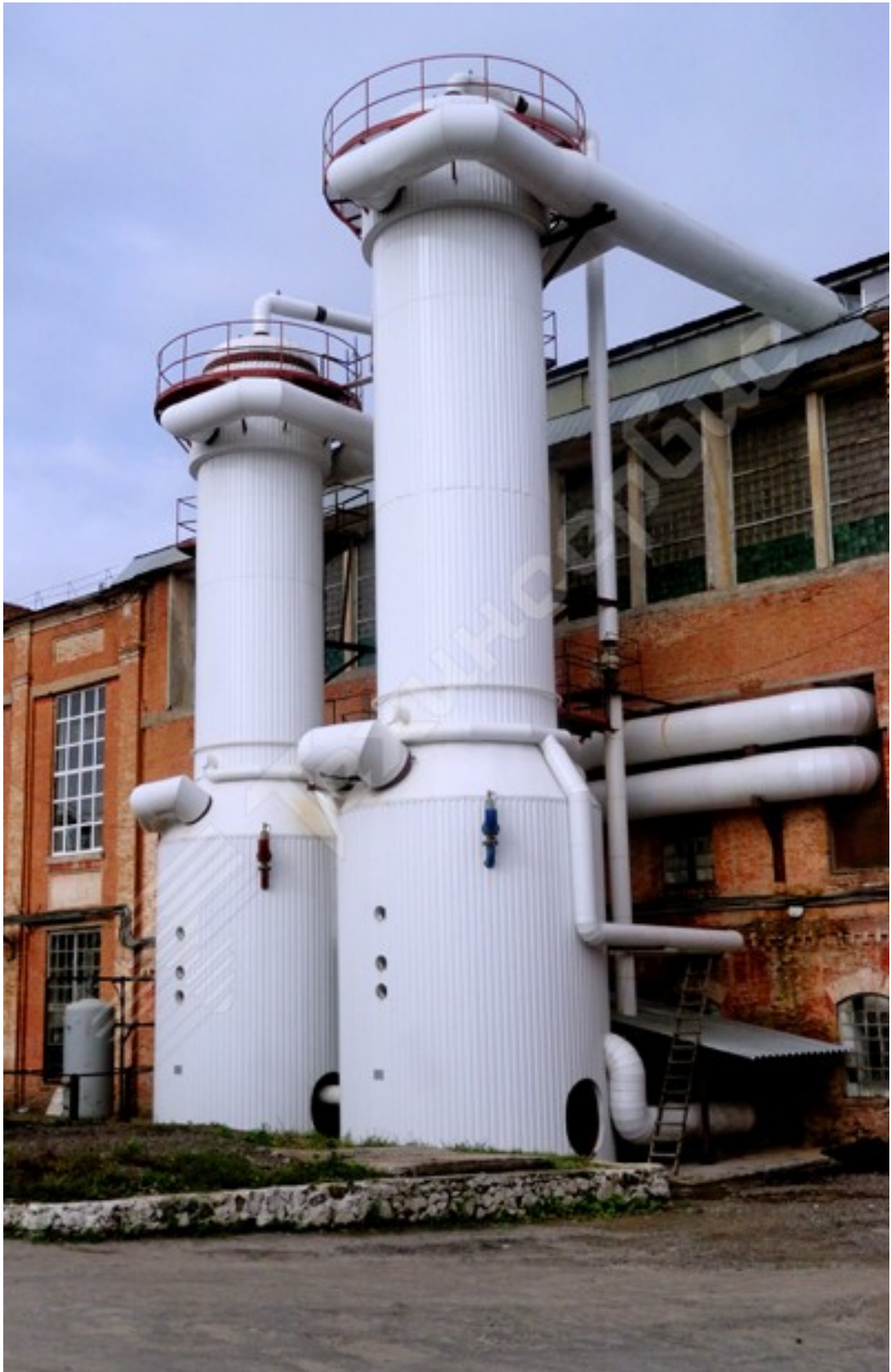
Рис.2.5. Розташування плівкових випарних апаратів за межами сокоочисного цеху.
