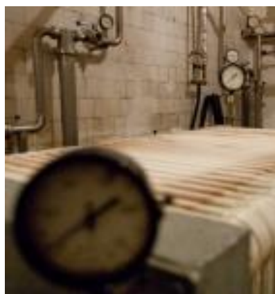
Рисунок 1.2 Теплообмінник пластинчатий
