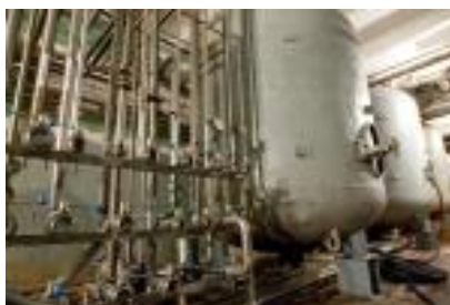
Рисунок 1.3 Циліндро-конічний апарат (ЦКБА)
