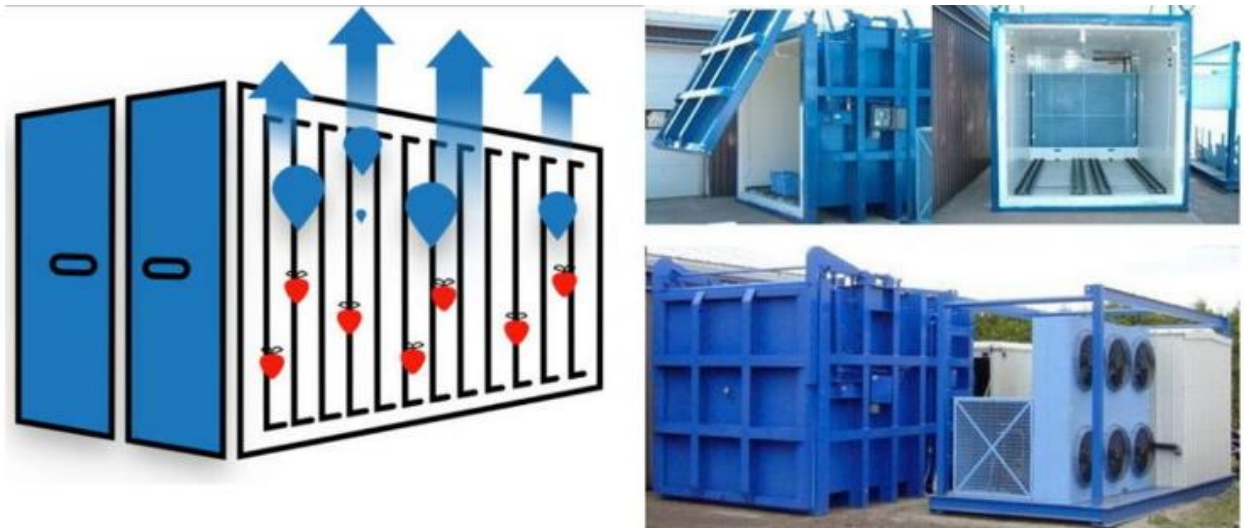
Рис 1.1 Камера для вакуумного охолодження листових овочів, фруктів, зрізаних квітів та салатів.
