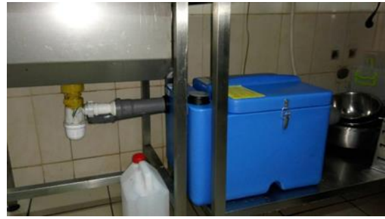
Рис.9 - Жировловлювач
