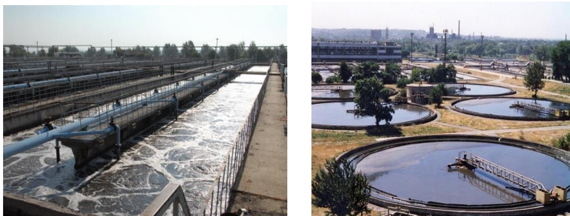
Рисунок 6.2 – Зображення повздовжнього аеротенка та аеротенка круглої форми
