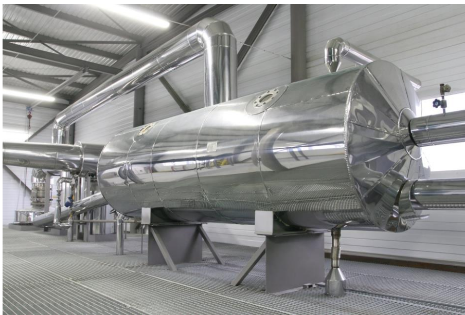
Рис. 2.1. Горизонтальний дезодоратор ТАН
