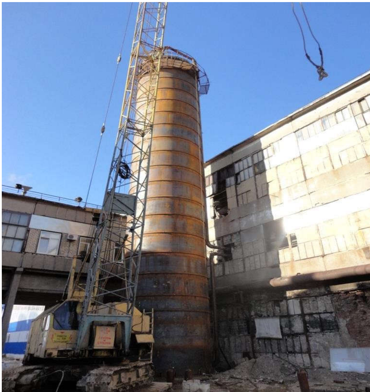
Рис. 15. Приклад монтажу вертикального перемішувача-кристалізатора ШІ-ПКВ фірми ТМА
