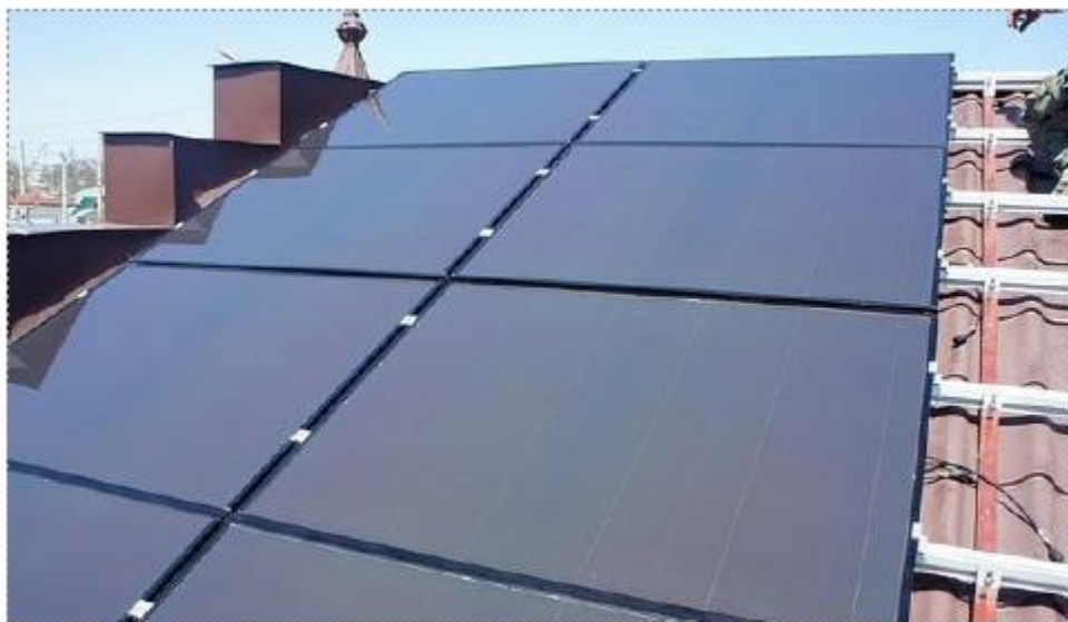
Рисунок 1.8 – Сонячна панель з аморфного кремнію
