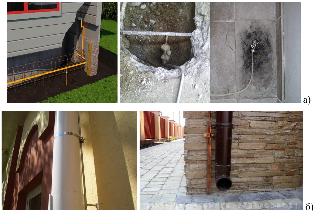
Рисунок 2.5 – Приклад виконання фундаментних заземлювачів [5].
