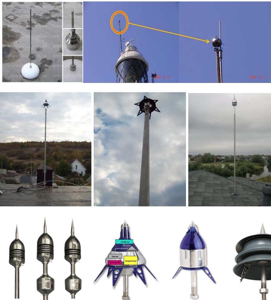
Рисунок 4.1 - Візуалізація активного блискавкозахисту [9].
