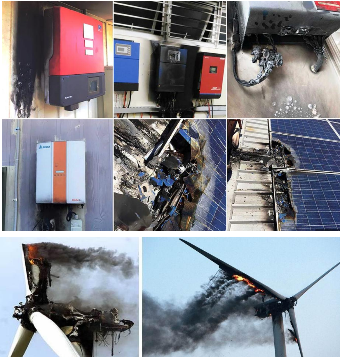
Рисунок 1.3 – У цьому випадку струм блискавки склав близько 50 кА і як слідство, удар блискавки фізично зруйнував частину генератора, при цьому спричинивши некоректну роботу або повну непридатність електричного устаткування [8-10].
