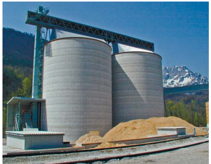
Рис. 8 – Силосний комплекс для зберігання деревного пилу
