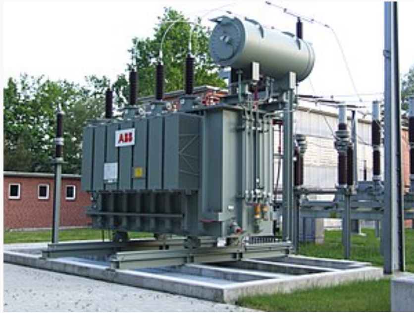
Трифазний силовий трансформатор трансформаторної підстанції відкритого типу
