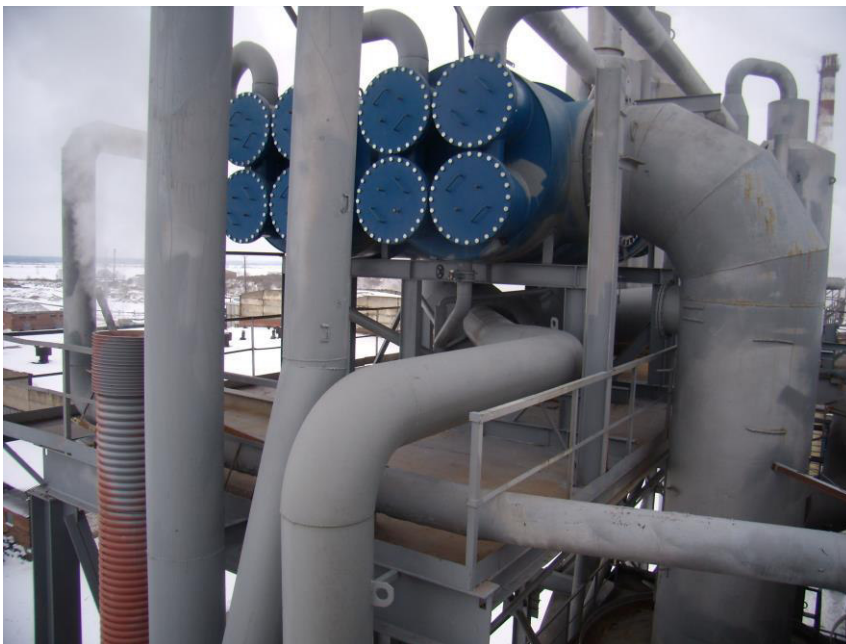
Рис. 3. Компоновка підігрівача на утфільній парі.
