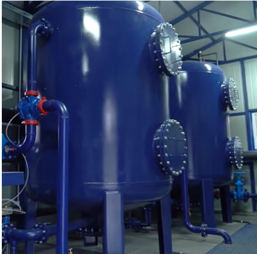
Рис. 1.3 Блок напірних фільтрів Organic FeM-2-8
