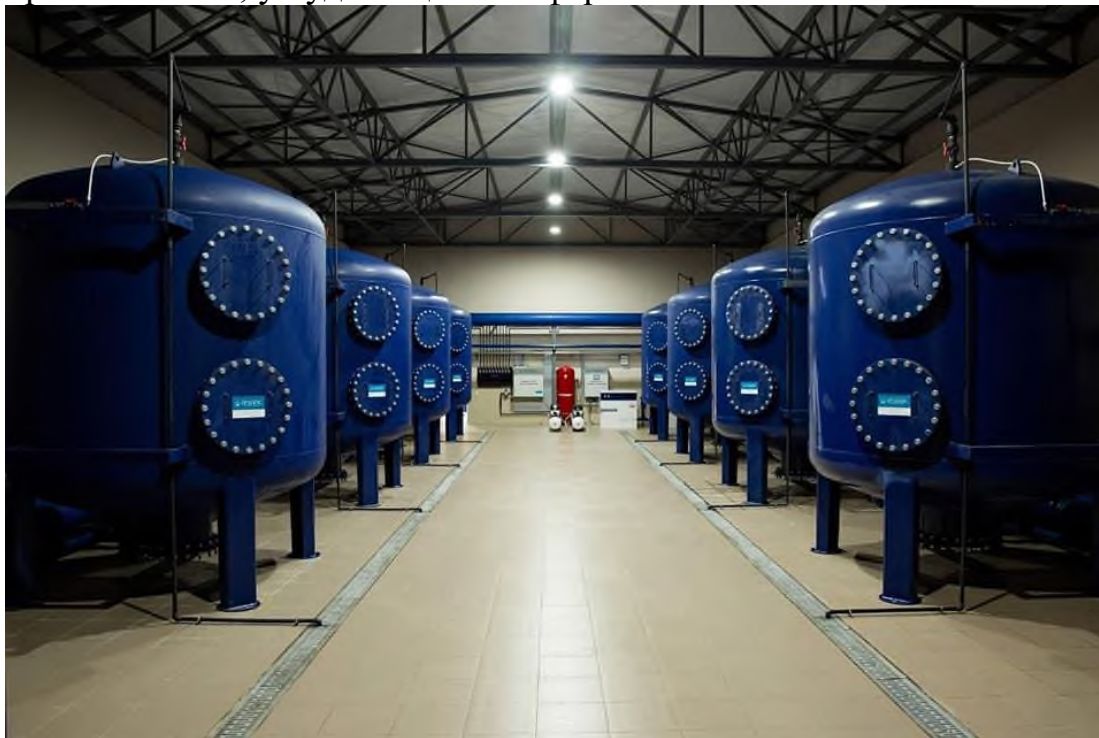
Рис. Комплекс напірних фільтрів Аквафор. Хоча компанія більш відома своїми рішеннями для домашнього використання, вона також пропонує рішення промислового застосування.
