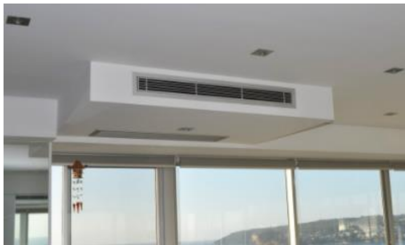
Рис.4.3 – Кондиціонери каналного та касетного типу
