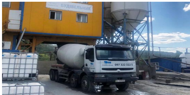
Рис. 2.1. Зображення заводу ТОВ «ТОРГБК «БУДІВЕЛЬНИК» [47]
