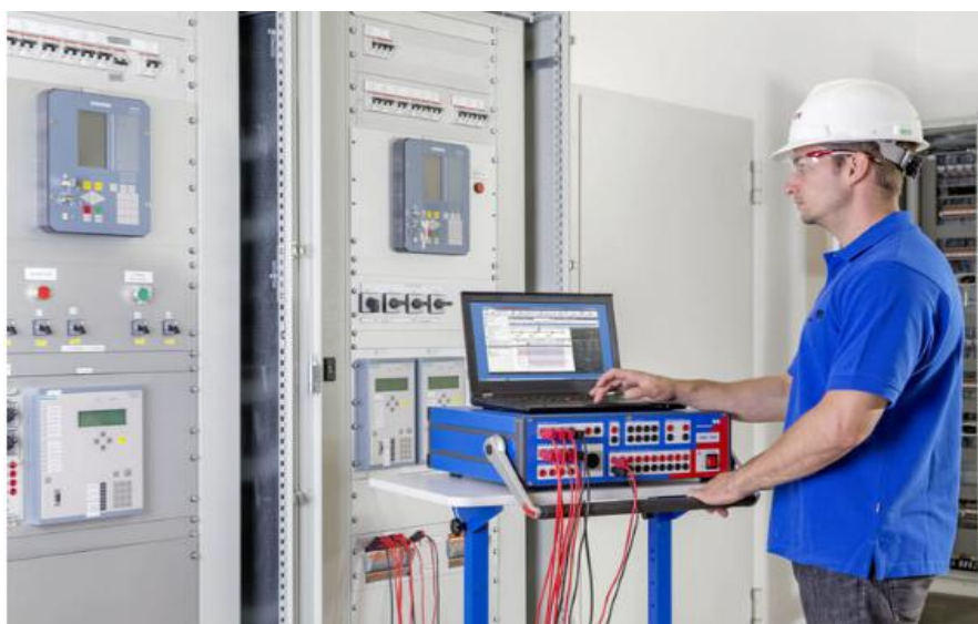
Рисунок 3. Підключення установки OMICRON CMC 356 з програмним забезпеченням до реле через роз'єм технічного обслуговування
