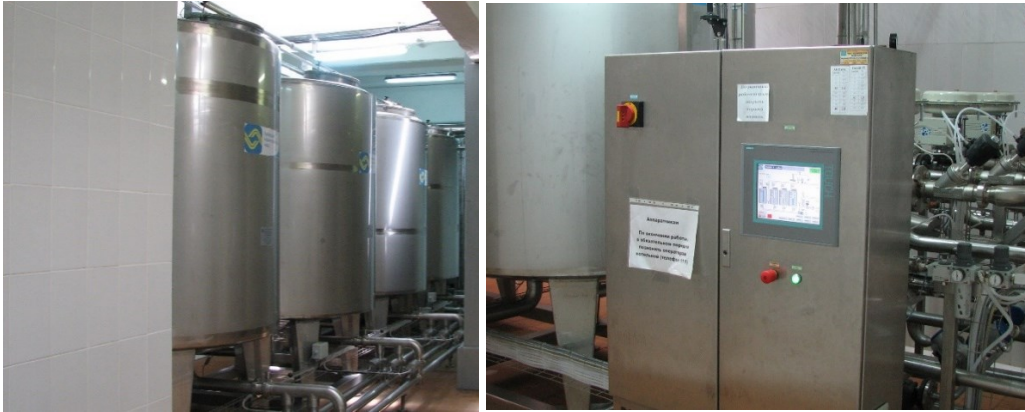
Рис. 10.2. Станція СІР-мийки [102].
