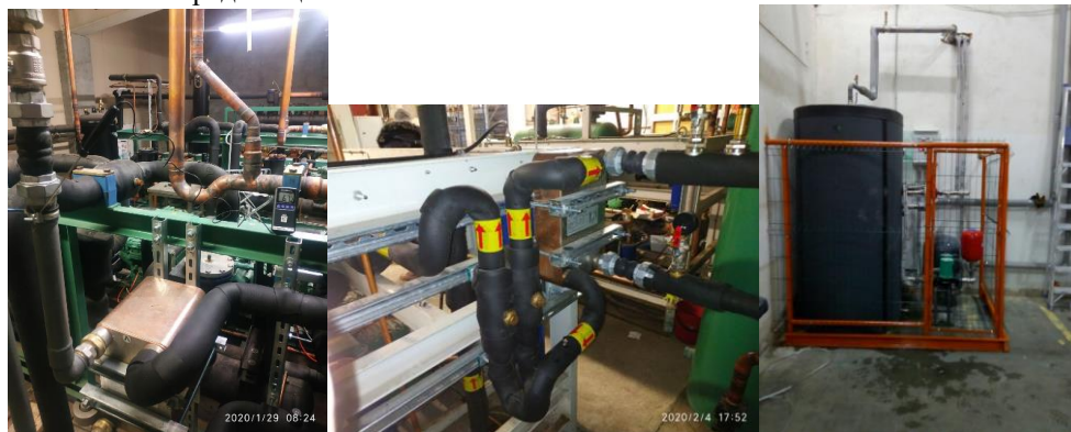
Рис.1. Розміщення пластинчастих теплообмінників та акумуляційного бака
