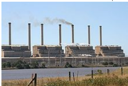
Рис. 2.1.1. Одна з димових труб теплової електростанції у штаті Вікторія (Австралія) випускає коричневий дим, при зупиненому електростатичному фільтрі
