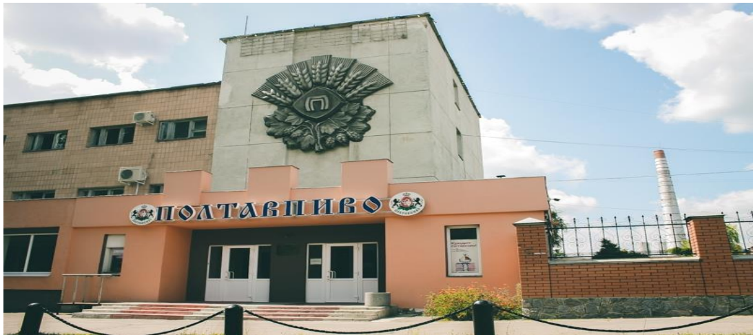
Рис.2.1. Центральний корпус ПрАТ «Фірма Полтавпиво» (м. Полтава)
