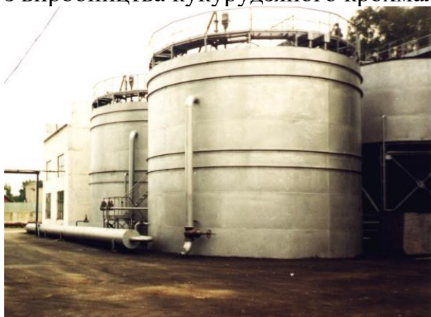
Рис. 1. Очисні споруди м'ясокомбінату
