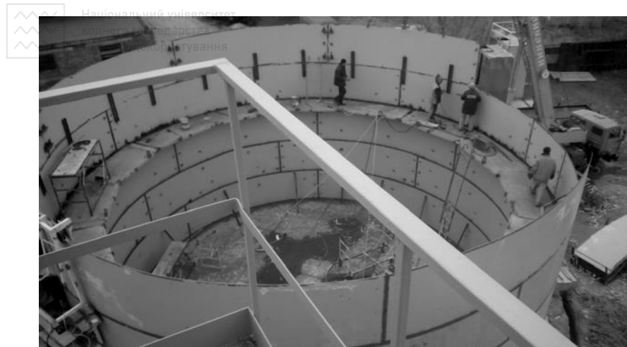
Рис. 15. Монтаж аеротенка-відстійника
