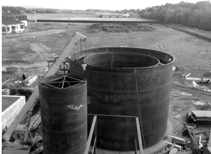
Рис. 14. Монтаж очисних споруд
