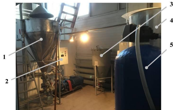
Рис. 3. Аераційно-окиснювальна установка роторного типу (АОРТ): 1 – збірник-накопичувач; 2 – аератор-окиснювач; 3 – фільтраційно-окиснювальна колона; 4 – розпилювальна головка; 5 – лічильник води; 6 – манометр; 7 – вакуумметр; 8 – кран подачі повітря; 9 – двоходовий кран.
