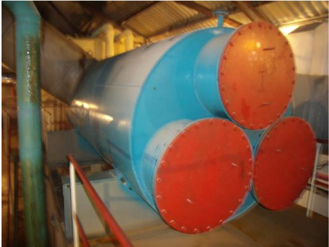
Рис.2. Швидкісний підігрівник дифузійного соку ПДС-1800-У
