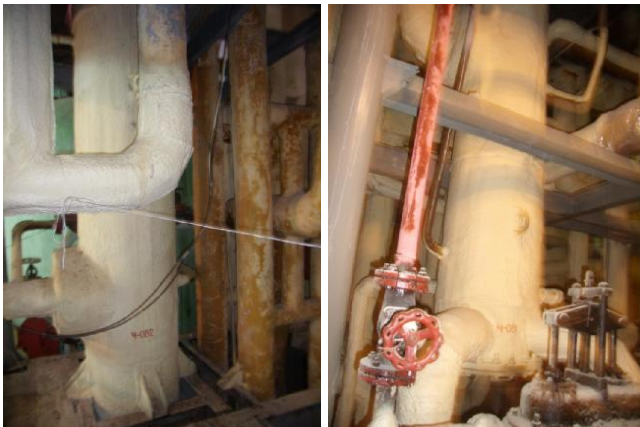
Рис.3. Швидкісний підігрівник соку перед 2 сатурацією ПСС-700
