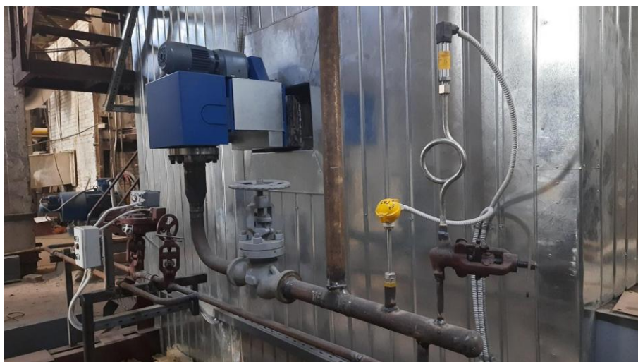
Рис. 11. Приклад встановлення парового обдувного обертового апарата
