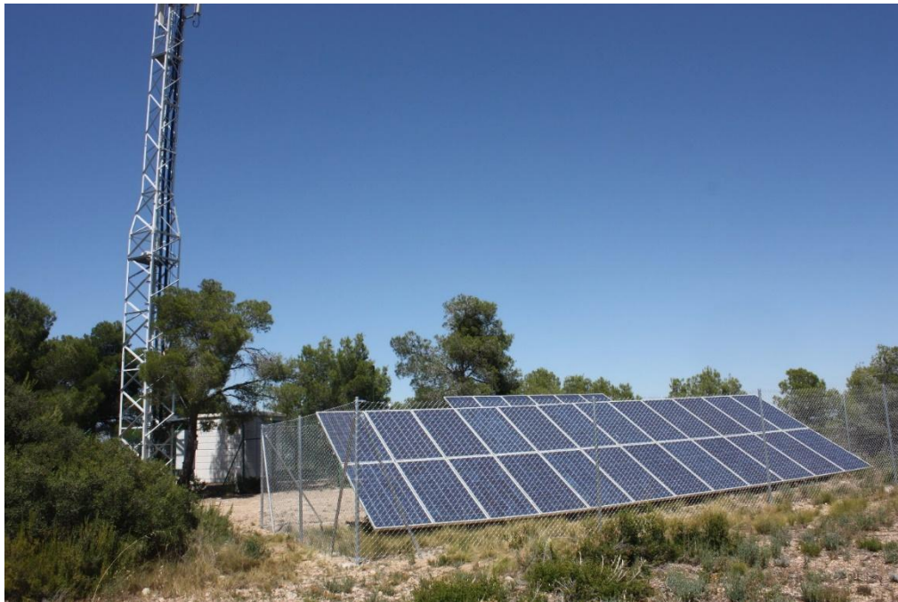
Рисунок 1.11 – Гібридна схема живлення БС від СЕС
