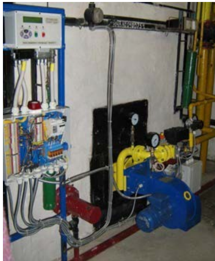
Рис. 4.7. Котел НИИСТУ-5 з палинковим пристроєм СНТ
