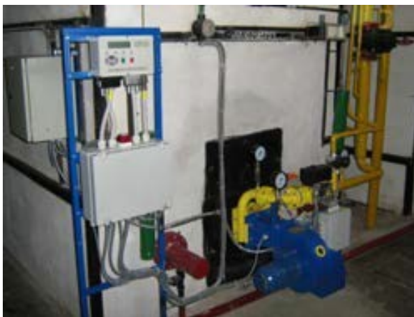
Рис. 4.8. Котел НИИСТУ-5, модернізований на основі СНТ
