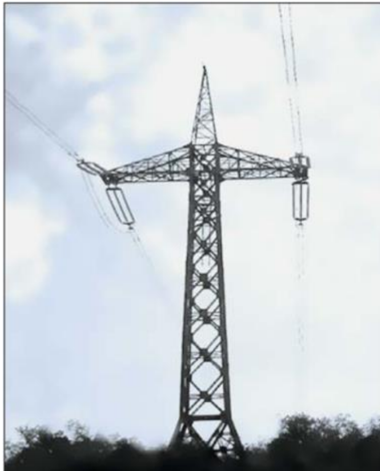
Рисунок. 1.7 – Опори для біполярної ЛЕП «Волгоград-Донбас» на напругу \pm 400 кВ
